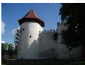
Foto 1- 6: Počas rekonštrukcie hradu a po rekonštrukcii
